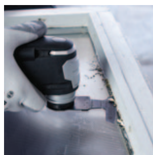
Řezání sklenářského tmelu (těsnicí hmoty)
